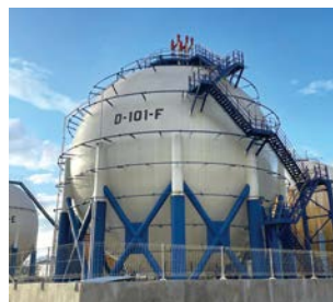
インドネシアでの球形タンクの施工事例
