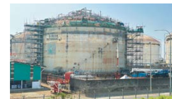
マレーシアでの低温タンク大規模改修工事事例
