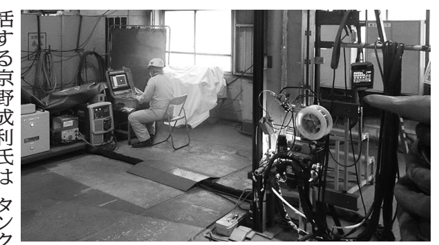
遠隔溶接システム
