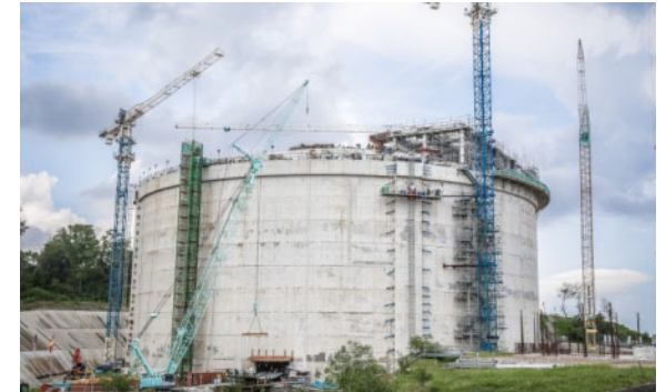
LNGタンク建設
