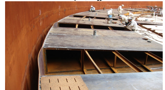
メンテナンス工事
