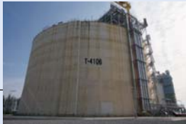
120,000m 3 PC LNG tank for Brunei LNG project (Brunei)
