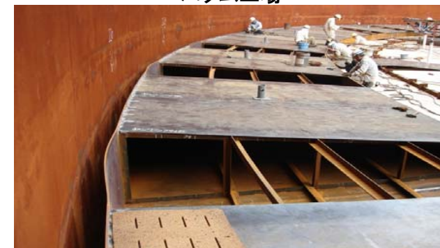
メンテナンス工事
