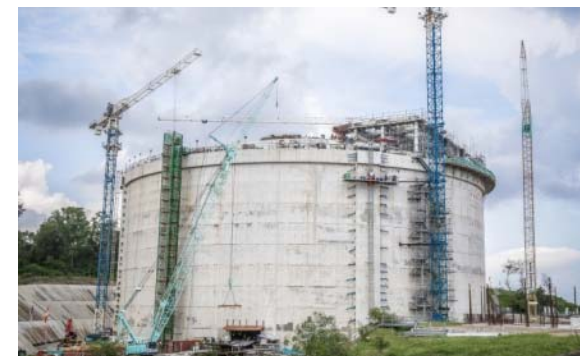
LNGタンク建設
