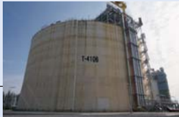
120,000m³ PC LNG tank for Brunei LNG project (Brunei)
