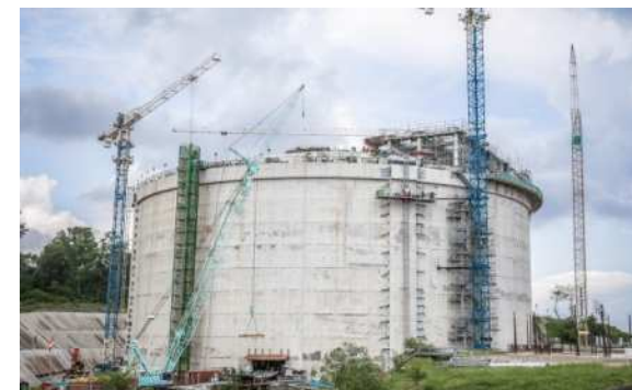
LNGタンク建設
