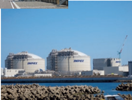
一番右のタンクは現在建設中のLPGタンク
