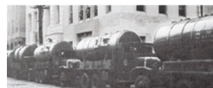
日本橋本社前に並んだ当社製ボイラーを積んだトラックの列
