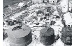
昭和石油(株)室蘭製油所に建設され た受注第1号タンク
