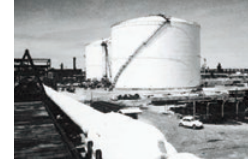
ブルネイで初受注したLNGタンク
