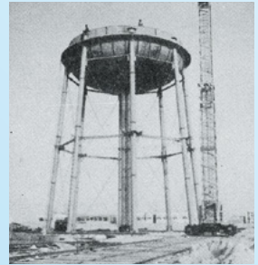
クウェートで建設中の高架水槽
