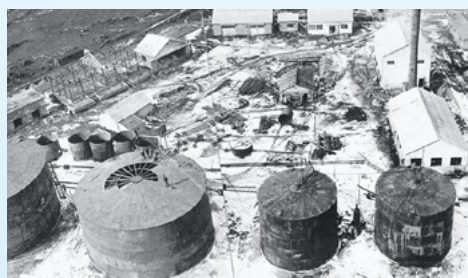
昭和石油(株)室蘭製油所に建設された受注第1号タンク
