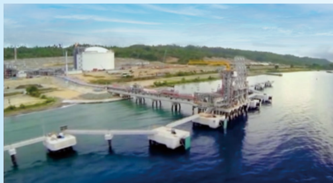
インドネシア ドンギ・スノLNGプロジェクトに納入のPC外槽式LNGタンク
