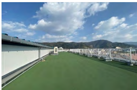
和歌山第3工場屋上
