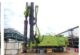
鋼管杭工事
