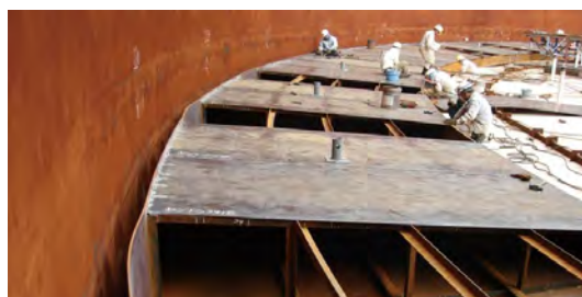
メンテナンス工事
