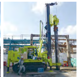
鋼管杭工事
