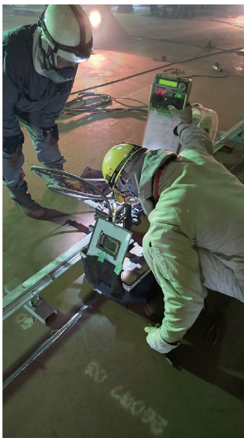
写真2 自動マグ溶接作業風景
