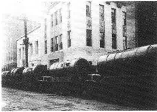
日本橋本社前(当時)に並ぶ、ボイラを積んだトラックの行列
