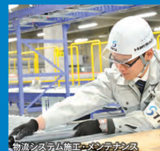
物流システム施工・メンテナンス
