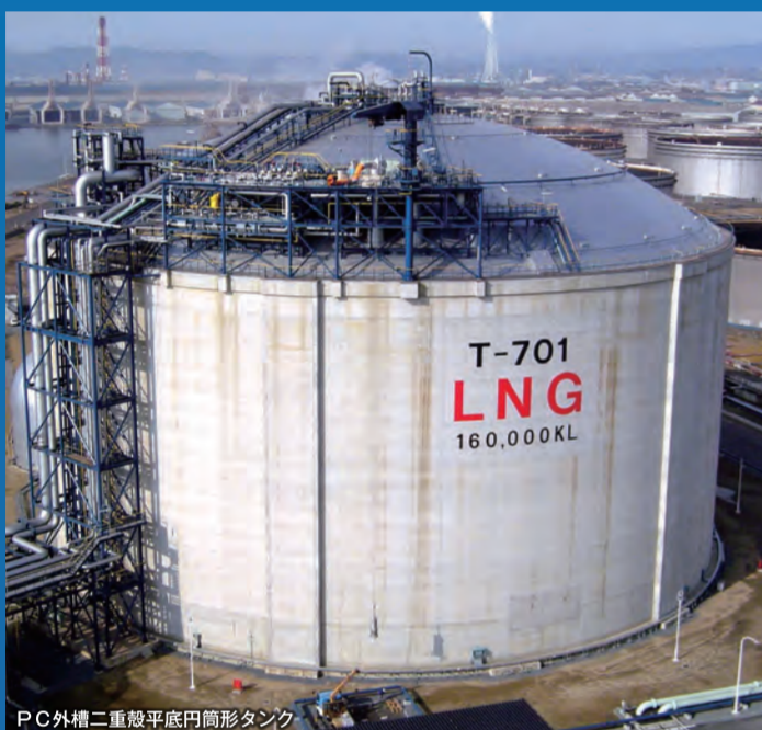
PC外槽二重殻平底円筒形タンク
